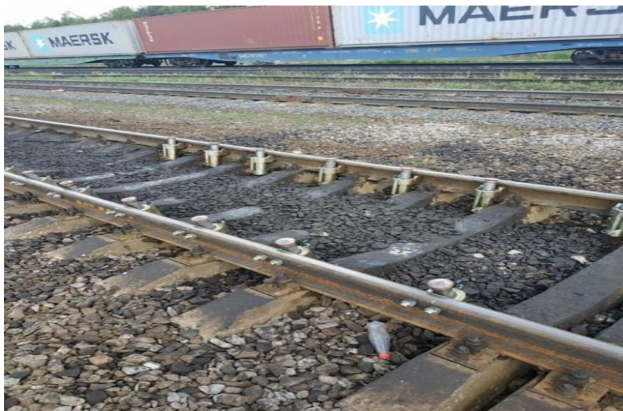
Рисунок 1 – Домкратовидные устройства закрепления
